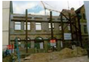
Bauphase: im Mai 1997
