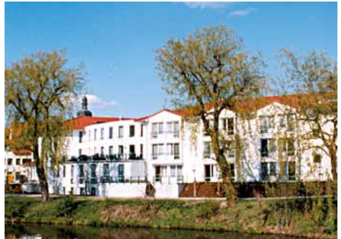
Blick von der Spree auf die Südseite der Einrichtung
