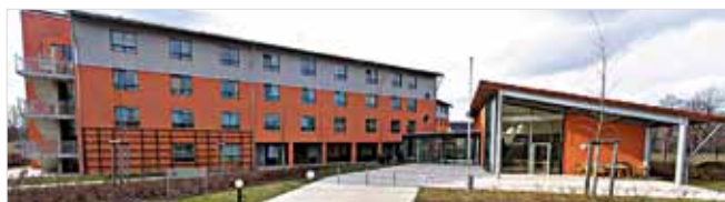
Blick auf den Eingangsbereich des Hauses
