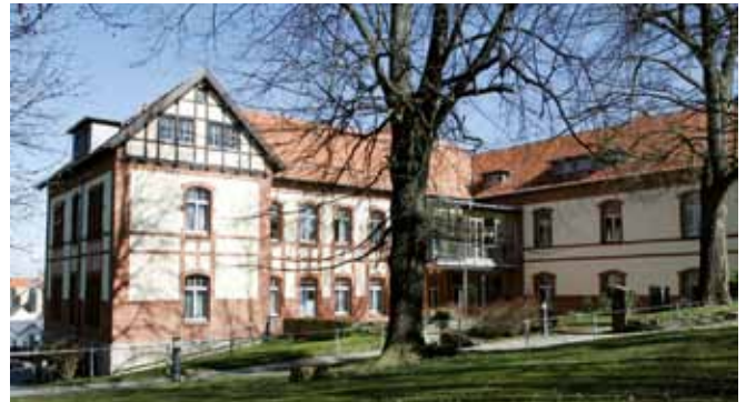
Haus Bethesda, Rückansicht mit Grünanlage nach Sanierung (2007)
