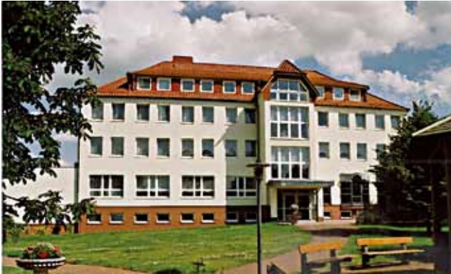
Seiteneingang Gebäudeteil I nach Sanierung (2003)
