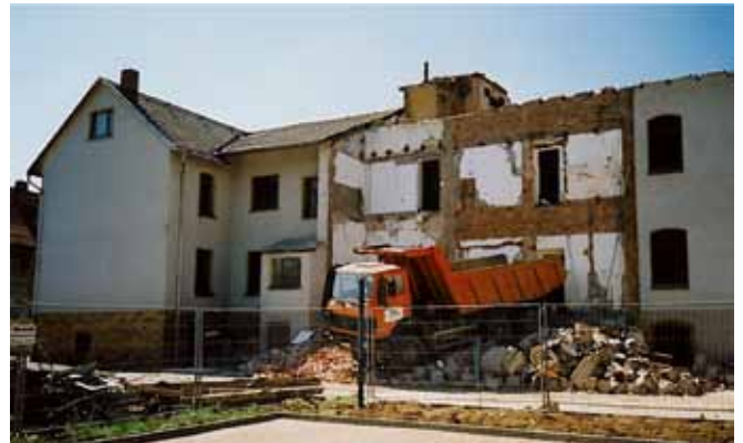
Gebäudeteil III, Beginn der Abrissarbeiten (1998)
