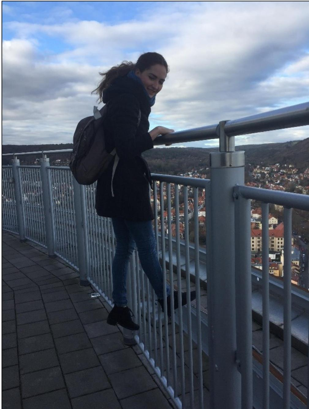
**Abb. 1:** Die Brüstungshöhe von 1.5m vor den suizidpräventiven Umbaumaßnahmen. Das Geländer konnte aufgrund des umlaufenden Drahtseils für die Fensterreinigung leicht überwunden werden.
