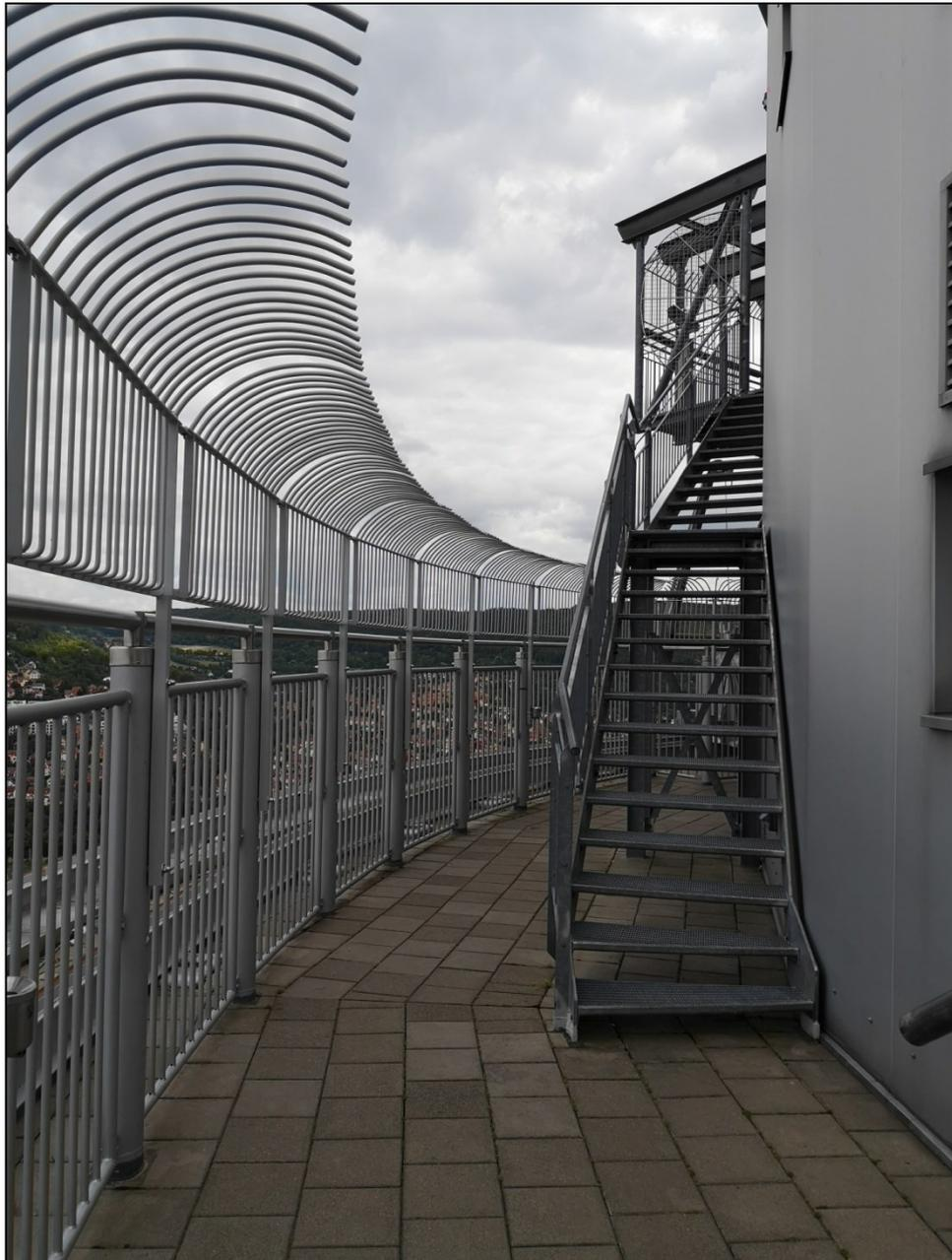
**Abb. 3:** Sicherung der Aussichtsplattform des JenTowers nach den Umbaumaßnahmen in den Jahren 2020-2021. Die vertikale Sicherung, also die Brüstungshöhe wurde auf ca. 2.60m umlaufend erhöht sowie nach innen gebogenen Spitzen angebracht, um das Überklettern des Geländers unmöglich zu machen.
